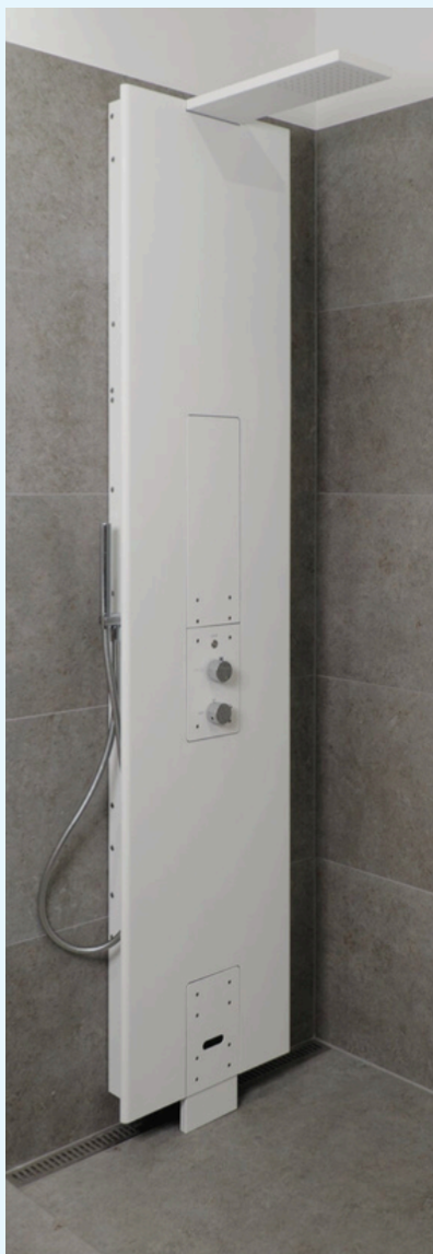
Færdig installation med linjeafløb.
